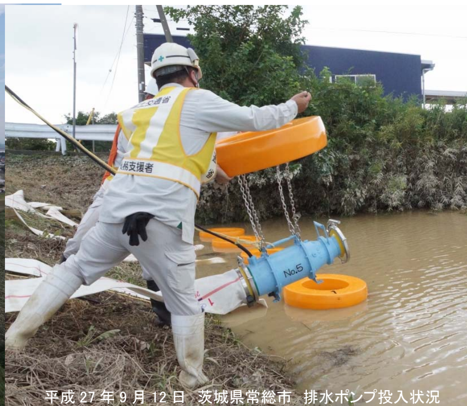
平成 27 年 9 月 13 日 茨城県常総市 排水作業状況
