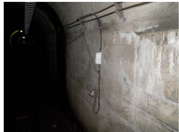
列車感知センサーの設置
