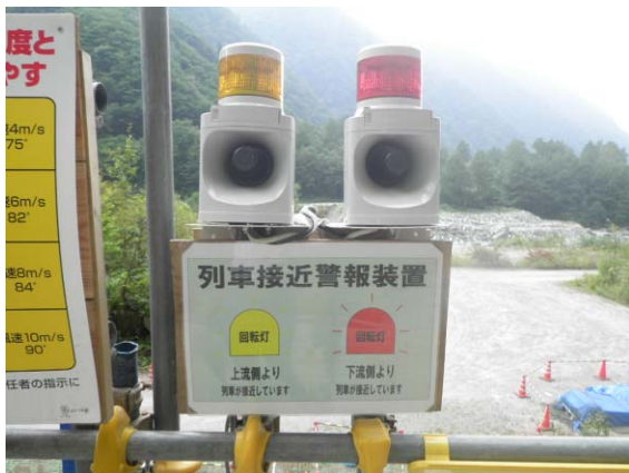
足場上に列車接近警報装置を設置
