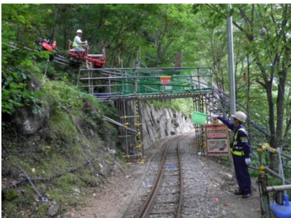
モノレール設置（軌道横断部）
